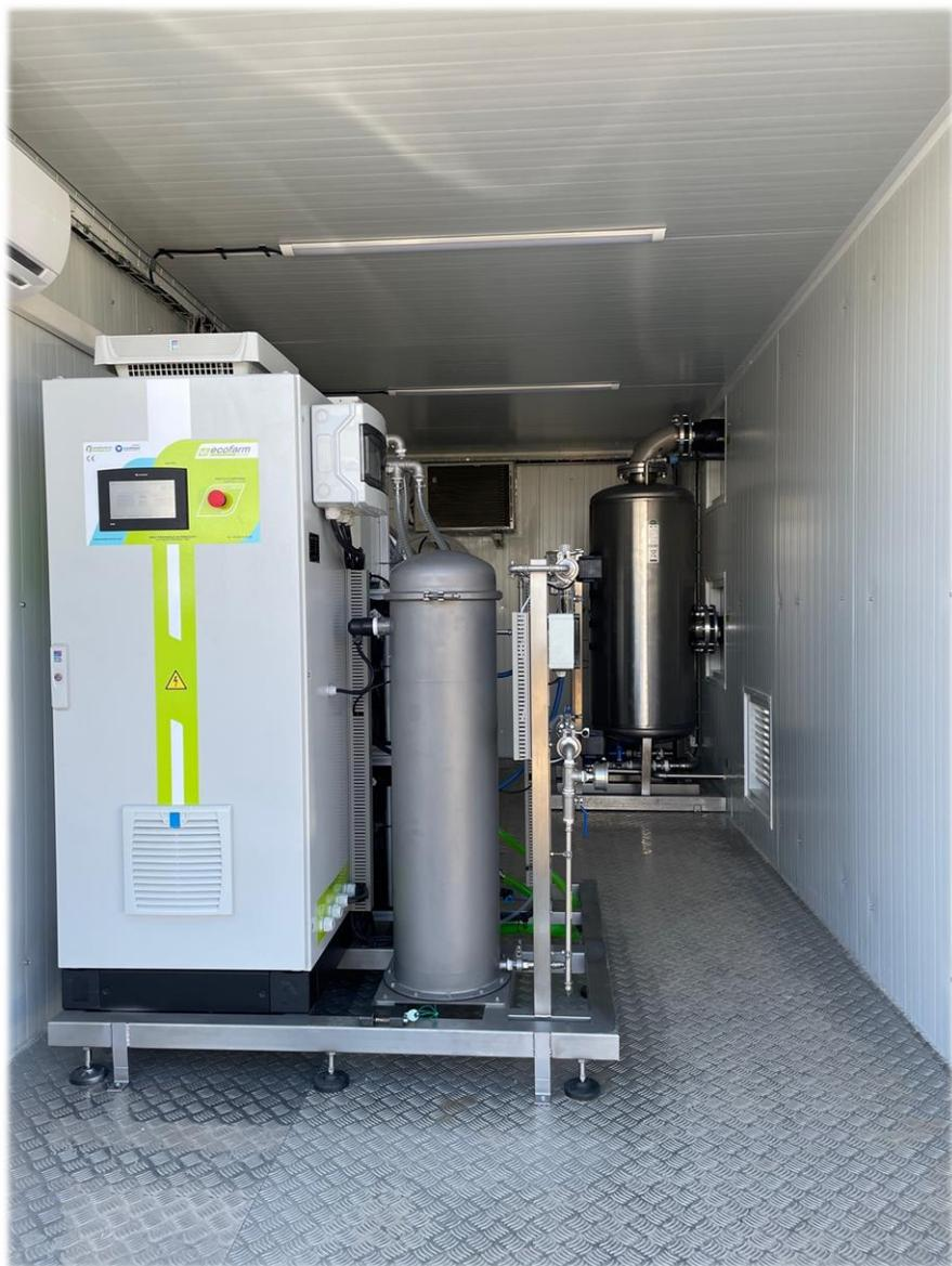
Versione containerizzata di un impianto per il trattamento di acqua di irrigazione in linea fino ad 200 m<sup>3</sup>/h
